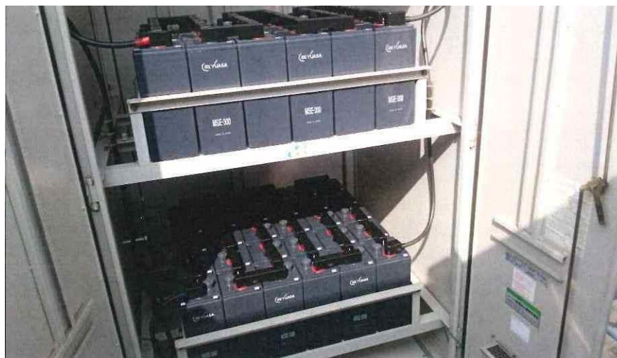
工事後(非常照明用蓄電池)
