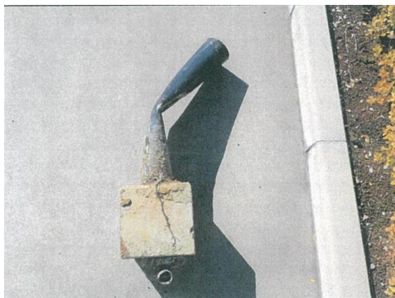
撤去した庭園灯
