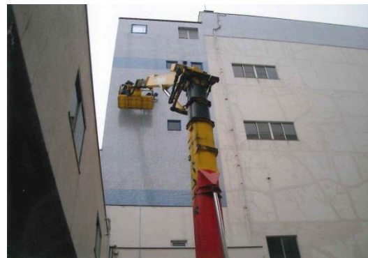
↑ クレーン車を用いた清掃作業 ↓
