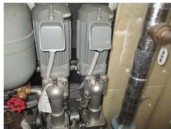
給水ポンプユニット取付け後
