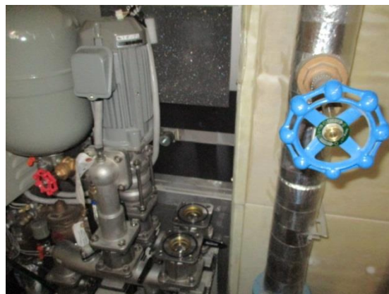
給水ポンプユニット取外し中
