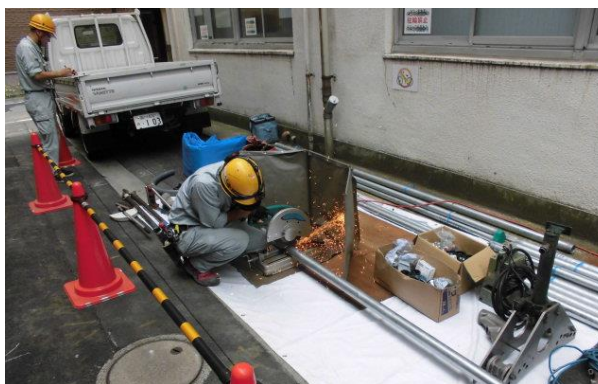
引込配管加工中
