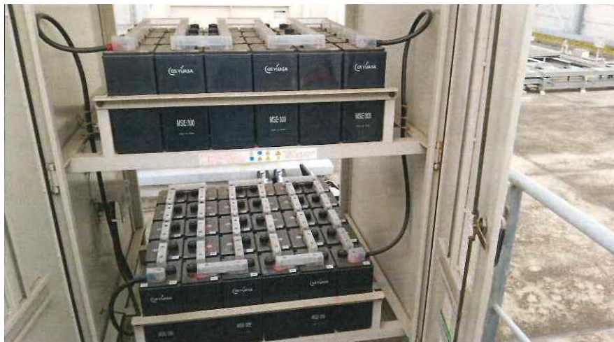
工事前(非常照明用蓄電池)
