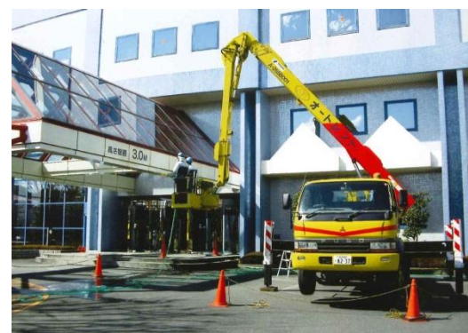
↑ クレーン車を用いた清掃作業 ↓
